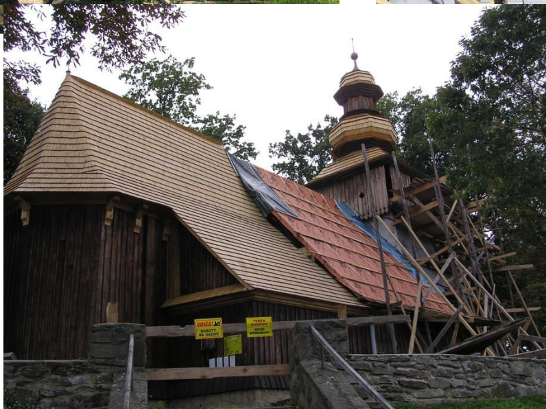
Poszczególne fazy remontu kościoła prowadzone w latach 2003 - 2006
